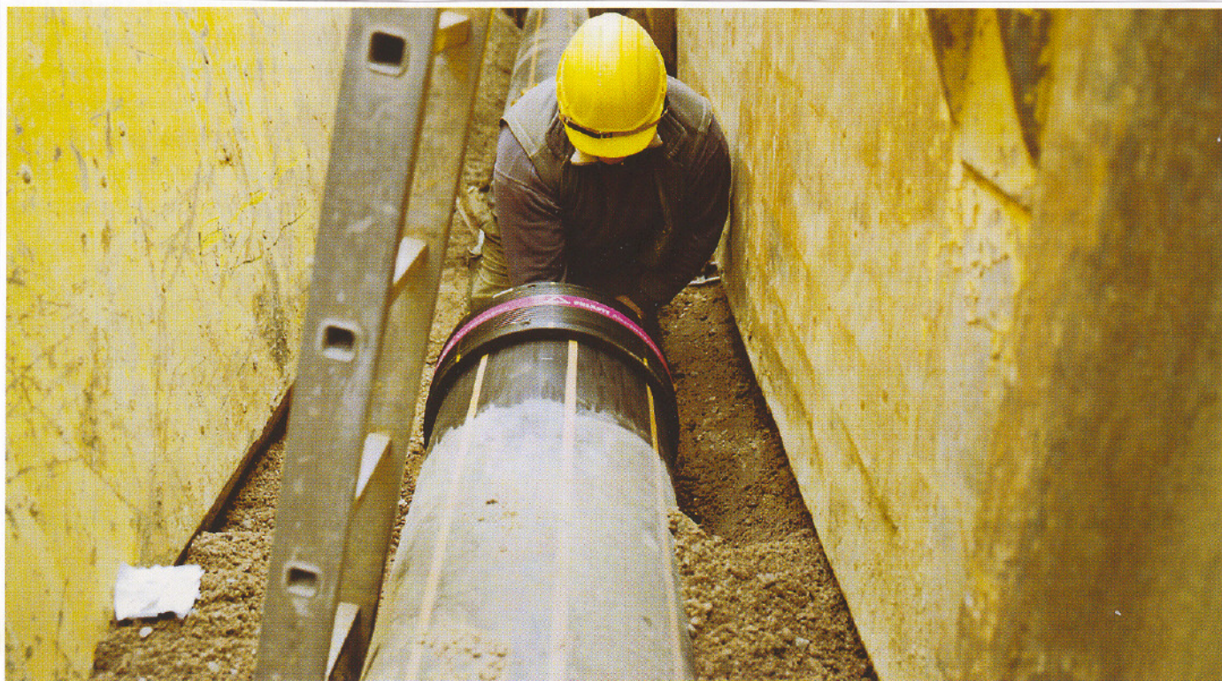
Рис. 1: Прокладка сточного трубопровода: сварка с помощью муфт FRIAFIT-AM.
